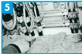
Einschneiden der Flumroc-Matte auf Kabelhöhe.
