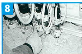
Zwischen den Anschlüssen mit Flumroc auffüllen.
