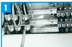
Ausmessen der Tiefe vom Kabel bis zur Kabinenwand.
