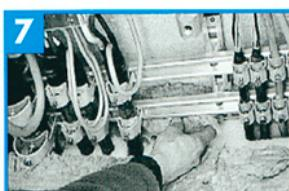
Hinter den Anschlüssen mit Flumroc auffüllen.
