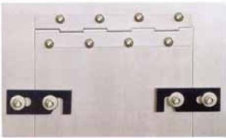
*Ein sicheres Verriegelungssystem auf der Innenseite der Türe arretiert die Türklappe, solange diese nicht benützt wird.*
