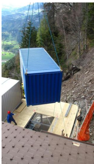
Eindrückliche Bilder vom Transportflug des Containers zum Podest bei der Materialseilbahn.
