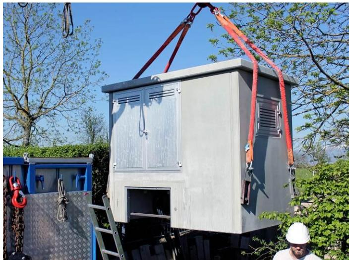
Il cliente ci fornisce il trasformatore e le celle di media tensione. In seguito noi abbiamo provveduto a integrare tutti i componenti nella cabina prefabbricata.
