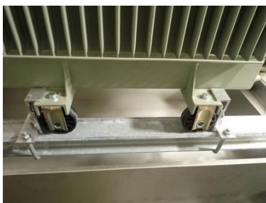
Abb. 1: Wegroll- und Abhebesicherung Transformator auf Laufschienen (Beispiel in Typ MIDI)
