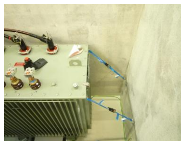
III. 2: Sécurité anti-roulement et anti-soulèvement, transformateur sur sol de bâtiment (exemple avec type TOSCANA)
