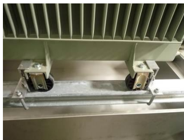
III. 1: Sécurité anti-roulement et anti-soulèvement, transformateur sur rail (exemple avec le type MIDI)
